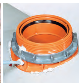
Z wkładem i rurką mieszającą żywica jest wprowadzana przez otwór wlewowy w pierścieniu dystansowym.
