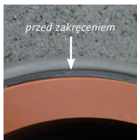
Przyłącze jest włożone. Uszczelka jeszcze nie docięgnięta.
